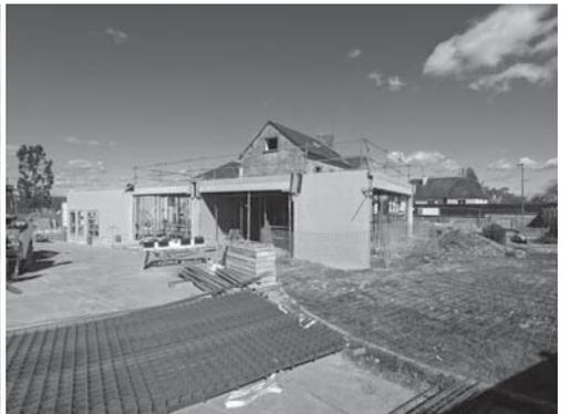
Du côté de l'ancien bâtiment, des étais viennent d'être placés côté rue de la croix de l'écu pour sécuriser une des fenêtres fragilisée suite aux travaux. Les élargissements de certaines ouvertures intérieures ont été réalisés et la charpente du corps de bâtiment côté cimetière devrait être déposée en mai. Lors de la démolition il avait été constaté la nécessité de la remplacer.
